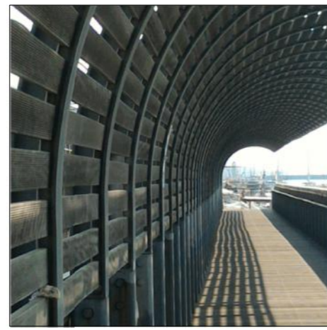
PONTE RIO SAN PIETRO
